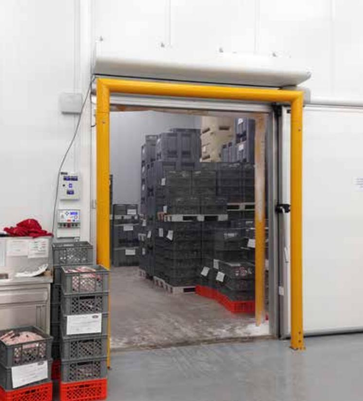
Test indipendenti dimostrano che una barriera a lama d'aria correttamente installata può ridurre le perdite di energia di una porta aperta fino all'80%. Una barriera a lama d'aria correttamente installata copre la larghezza e l'altezza dell'apertura e si adatta alle circostanze a cui è esposta.
