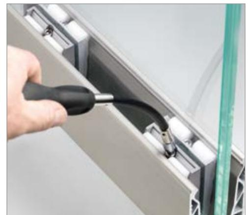
**6** Regolazione dall'alto del pressore in alluminio preinstallato, con ausilio di giravite a testa esagonale. Velocità di regolazione massimizzata. E' possibile completare la regolazione con l'ausilio di avvitatore. **Coppia di serraggio 3 Nm.**
