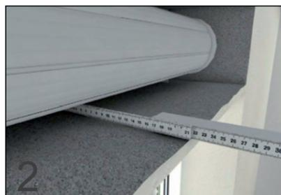
2 Misurare il vano interno del cassonetto per determinare la lunghezza e lo spessore dei pannelli isolanti.
