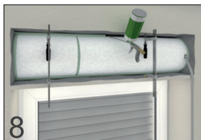
8 Incollare ed ermetizzare i pannelli isolanti alla battuta e nelle zone di giunzione con della schiuma per montaggio a bassa espansione.
