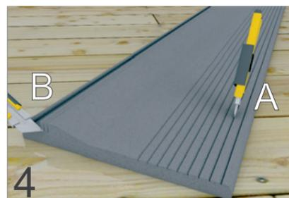
4 Grazie ai punti di taglio predefiniti, tagliare la base rigida per il pianale del cassonetto in funzione della larghezza necessaria (A) e dello spessore di isolamento di CLIMA-FLEX (B).
