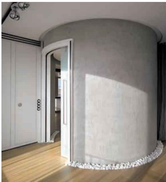
Ogni controtelaio ECLISSE CIRCULAR viene realizzato ad hoc a partire dalle misure di luce di passaggio e dal raggio di curvatura. Molte fasi della lavorazione avvengono ancora a livello artigianale. Il telaio è costruito con doghe di lamiera agganciate, larghe 10 cm, per massimizzare la consistenza della struttura. ECLISSE CIRCULAR è anche straordinariamente flessibile: il raggio di curvatura possibile va da 1 fino a 5 metri.
