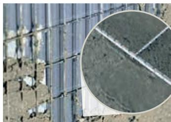
L'INTONACO NON CADE quando lo si applica perché sostenuto da una rete zigrinata molto fitta (25x50) posta proprio fra lamiera e filo dell'intonaco.
