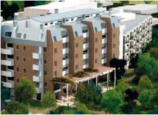
Casa Fenzi Conegliano - Treviso
